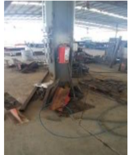
Figura 10. Extintor sin Acceso
