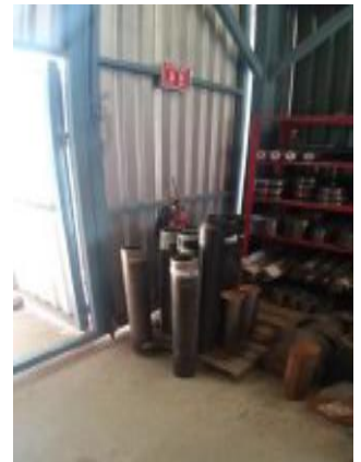
Figura 6. Extintor sin Visibilidad
